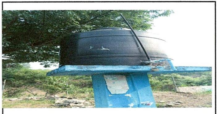
Foto 12: Sustitución de deposito de agua 1,700 lt.
