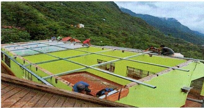
Foto 3: Colocación de estructura de soporte.
