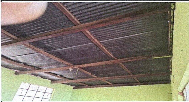
Foto 3: sustitución de estructura de soporte
