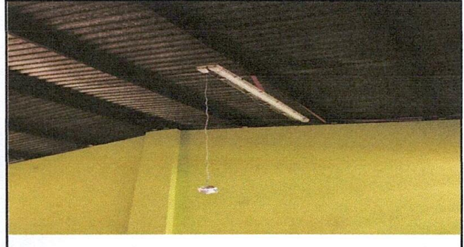
Fotos. 4 Sustitucion plafoneras por deterioro.
