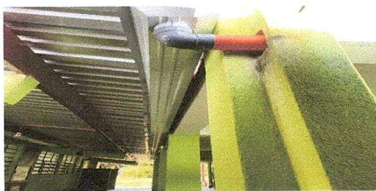
Foto 6: Canales y aguas pluviales en buen estado,
