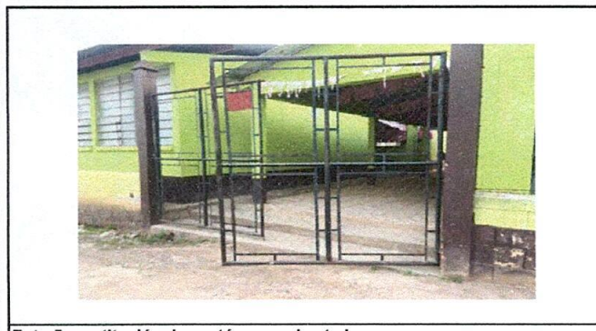
Foto 5: sustitución de portón en mal estado
