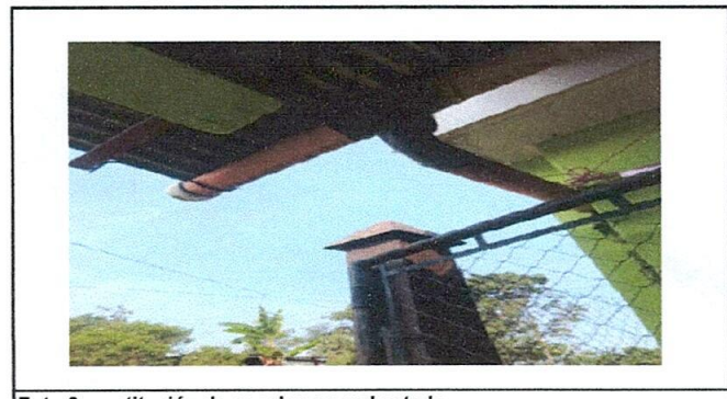
Foto 6: sustitución de canales en mal estado
