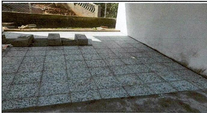
Foto 3: PISO GRANITO POR TORTA DE CEMENTO
