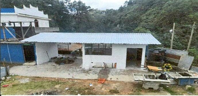
Foto1: COLOCACIÓN DE LÁMINA
