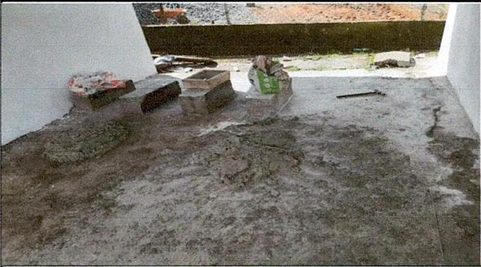
Foto 3: COLOCACIÓN DE PISO GRANITO
