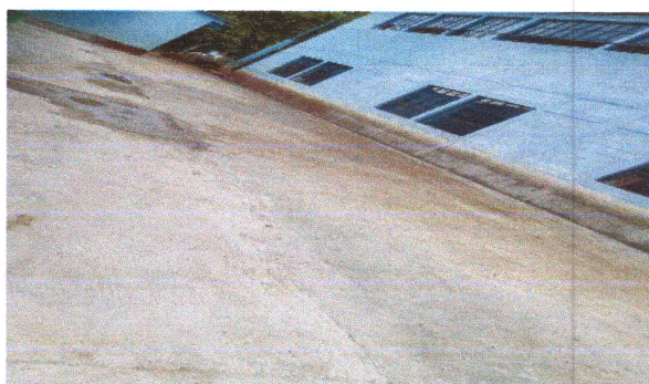
Foto 5: sustitución de pavimento en el corredor
