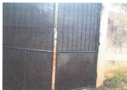
Foto 6: Sustitución de portón
