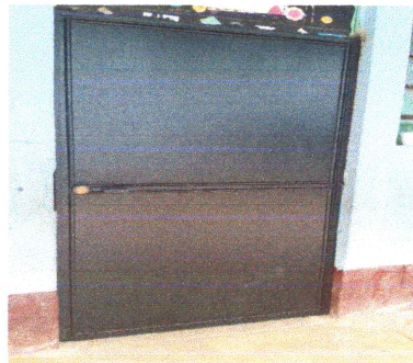
Foto 2: sustitución de puertas de metal
