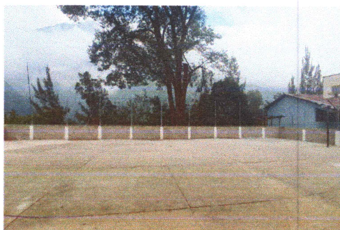
Foto 1: Reparación de muro perimetral 5 hiladas de blok, malla
