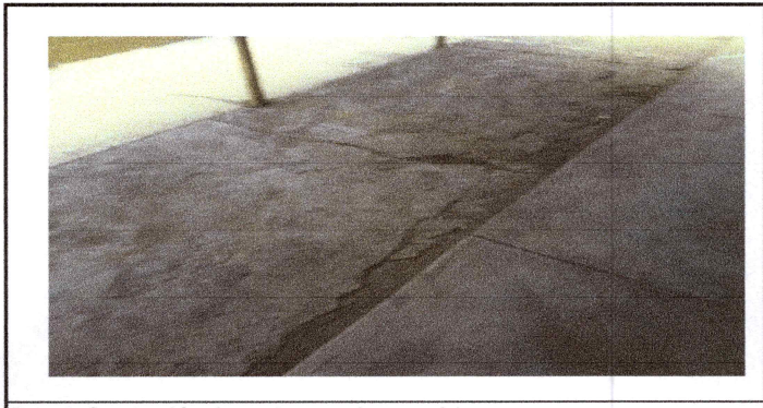
Foto 5: Sustitución de pavimento de corredor
