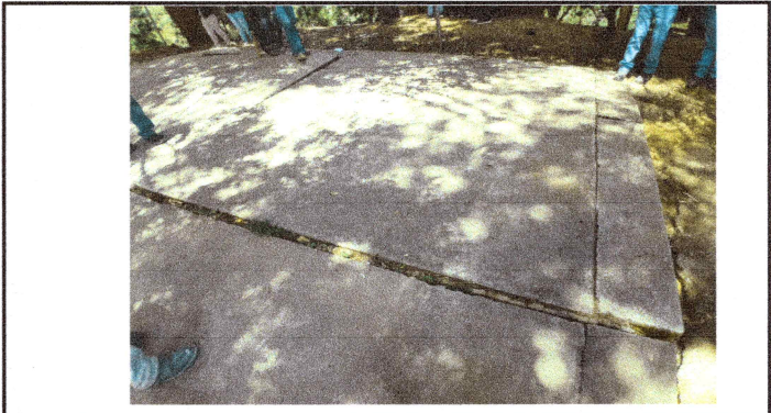
Foto: 4 Sustitución de pavimento de cancha
