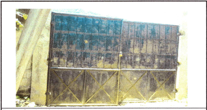
Foto 6: Sustitución de puertas
