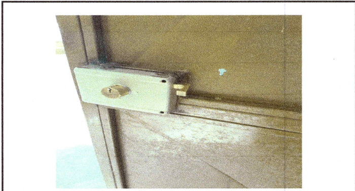
Foto 3 Sustitución de chapa de puerta de metal
