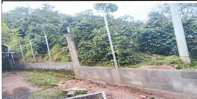
Foto 5: Muro en proceso
