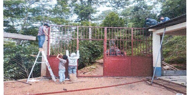
Foto 4: Colocación de Portón
