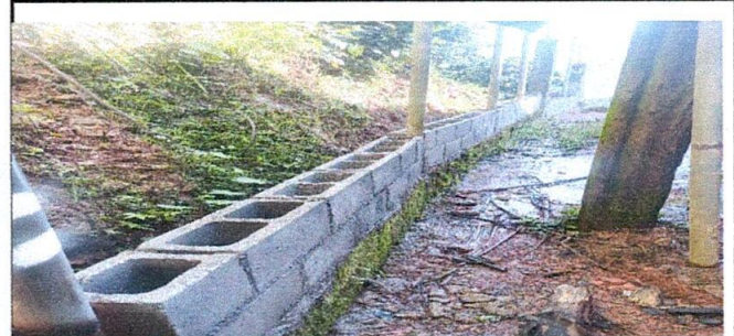
Foto 6: Construcción de muro
