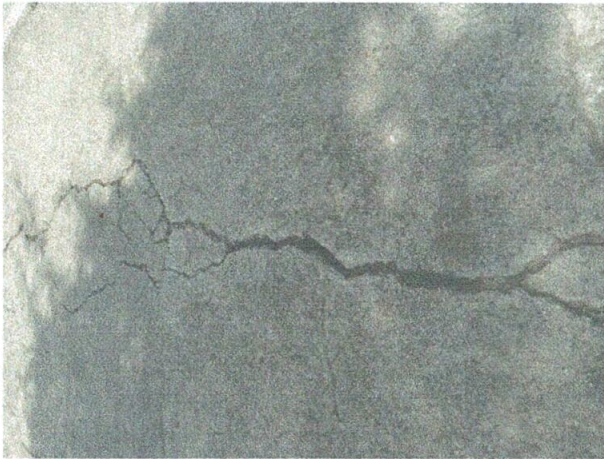
Foto 1: Cambio de pavimento.
