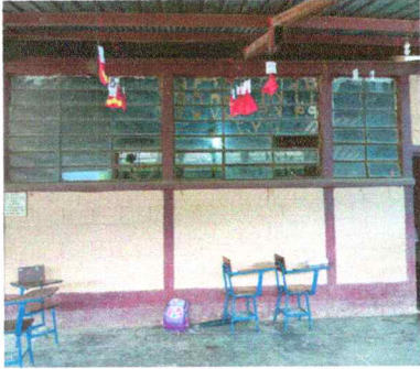
Foto 7: Sustitución de vidrios
