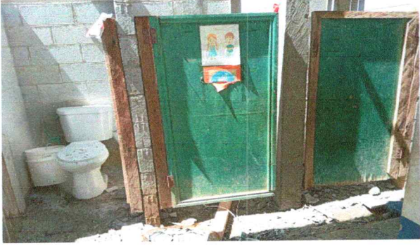
Foto 1: Sustrucción de puertas
