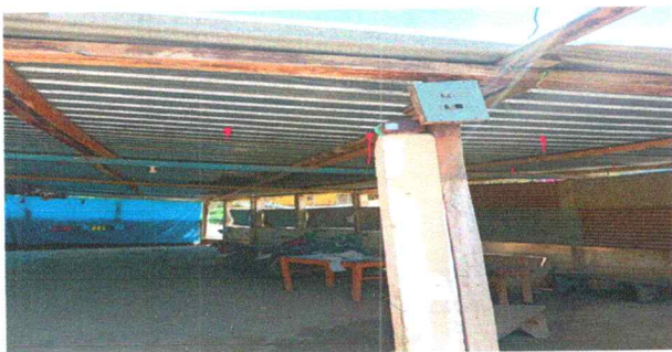
Foto 5: Sustrucción de estructura de soporte de techo
