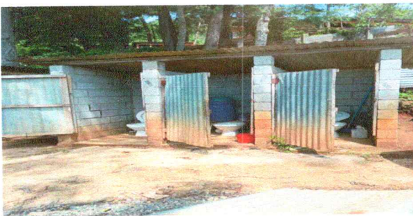
Foto 3: Sustrucción de puertas
