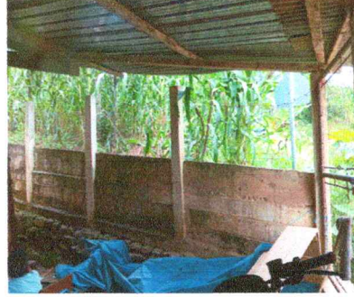
Foto 8: Mejoramiento de pared
