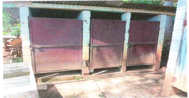
Foto 2: Sustrucción de puertas
