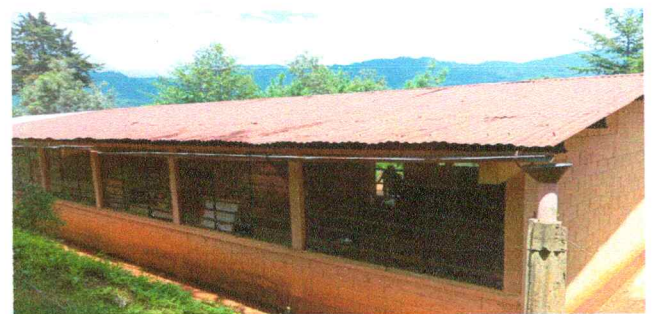
Foto 6: Sustrucción de canales
