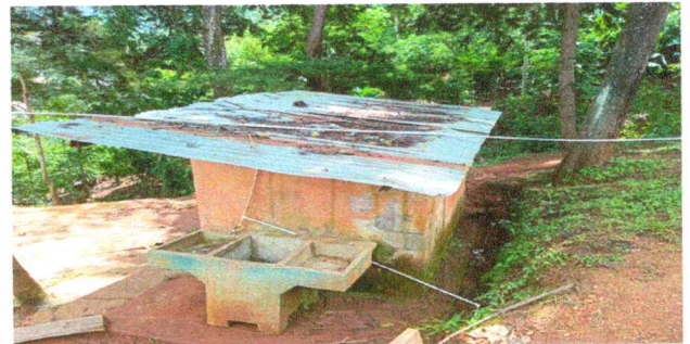
Foto 4: Sustrucción de estructura de techo + lámina
