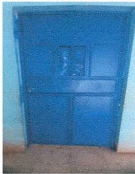
Foto 3: mantenimiento a puertas de aulas
