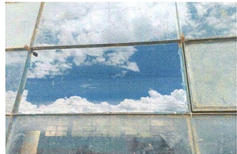
Foto 6: colocación de vidrios faltantes
