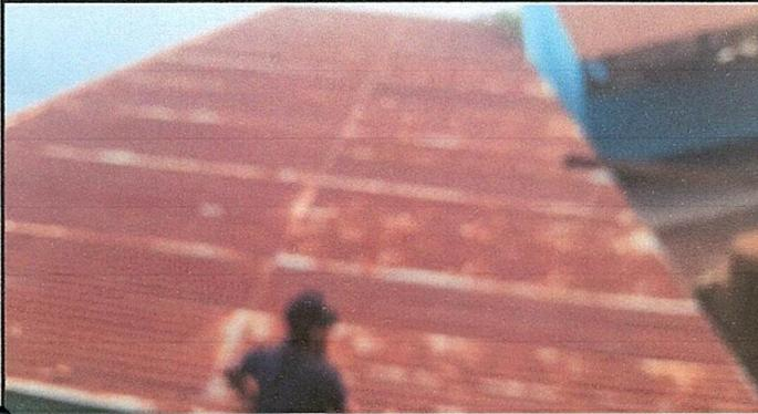
Foto 1: Cambio de techo de lámina por láminas troqueladas calibre 26
