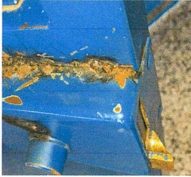
Foto 1. Sustitución de chapas
