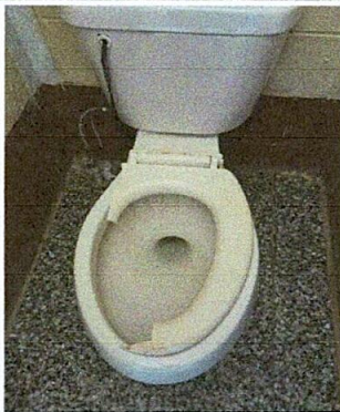
Foto 3. Sustitución de accesorios de baño
