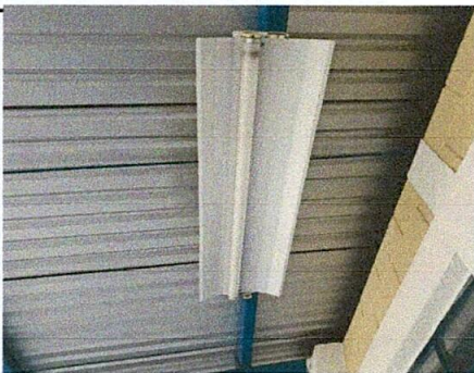
Foto 5. Sustitución de lámparas
