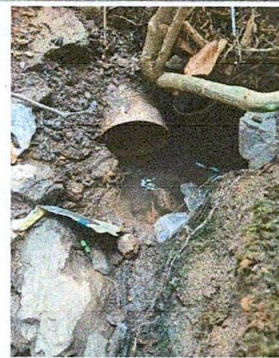
Foto 4. Sustitución de tubo pvc línea principal de aguas negras
