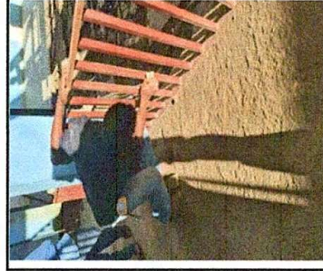
Foto 3: mantenimiento de Barandas
