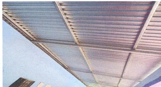
Foto 2: Colocación de lamina troquelada calibre 26 y estructura portante de metal.
