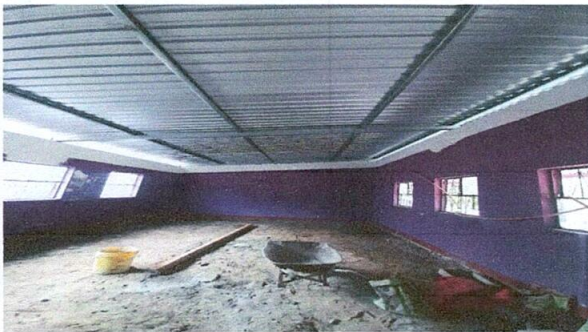
Foto 3: Cambio de piso de concreto en las aulas.
