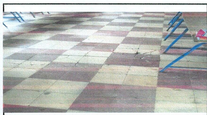
Foto: 4 Colocacion de Piso de Concreto en las Aulas
