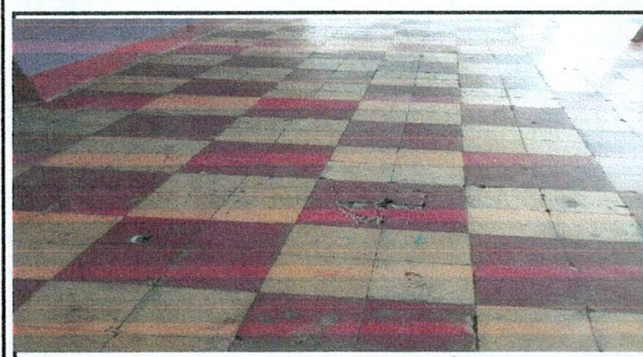
Foto.3 Cambio de piso de concreto en las Aulas por deterioro del mismo
