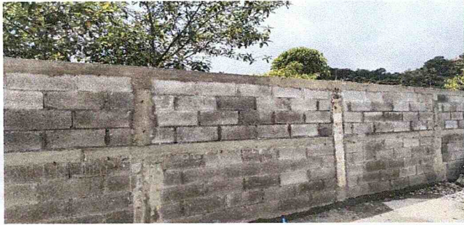
Foto 3: Muro Perimetral Construido
