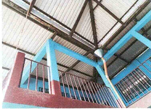
Foto 1: Sustrucción de Láminas instaladas
