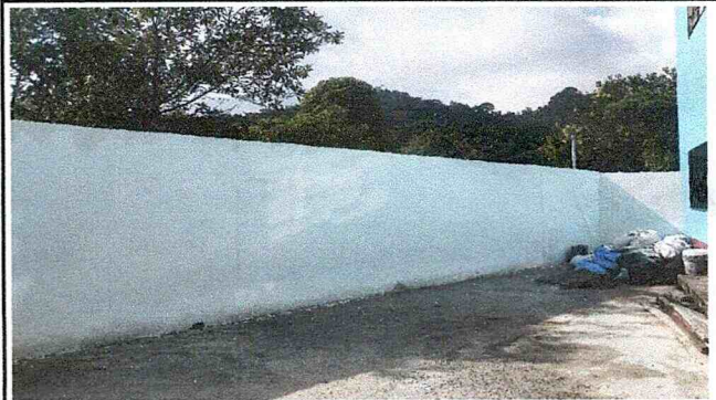
Foto 4: Muro Perimetral Detallado
