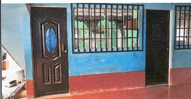
Foto 5: Instalación de puertas
