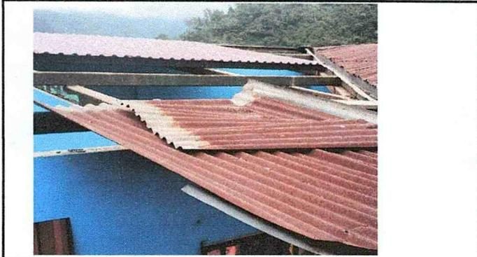
Foto1: Sustitución de Láminas en proceso
