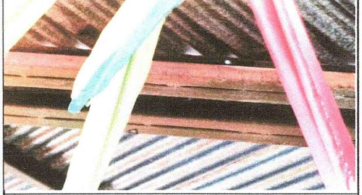
Foto 2: sustitución de lámina por traquelada
