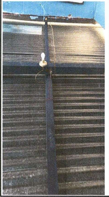
foto:2 sustitución de estructura de soporte de madera por metal
