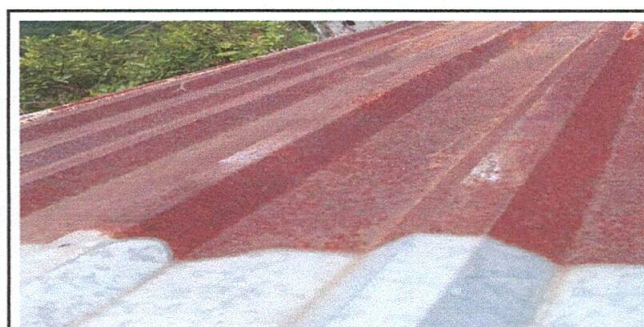
Foto 6: Sustitución de Lamina
