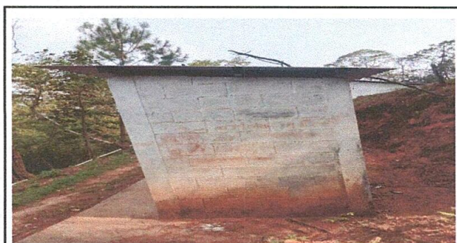
Foto 5: Sustitución de paredes de baños
