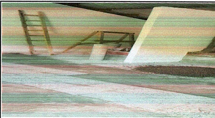
Foto 9: Sustituyendo el piso de torta por el piso de granito
