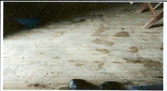
FOTO 9: Sustitución de piso de torta de concreto po piso de granito
