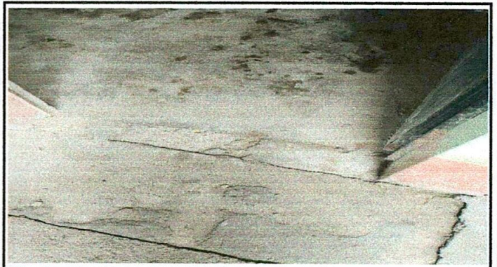
FOTO 8: Sustitución de piso de torta de concreto por piso de granito
