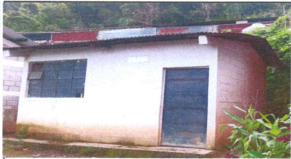
Foto 1: Sustitución de vidrios en ventana y sustitución de chapa en puerta
