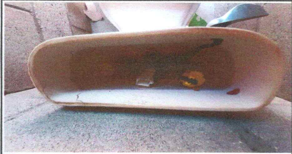
Foto 8: Sustitución de accesorios inodoro
