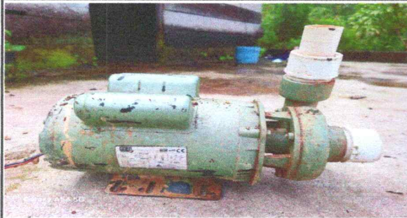
Foto 7: Sustitución de bomba de agua
