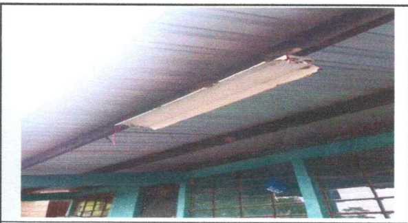
Foto 6: Reparación de Sistema Eléctrico
