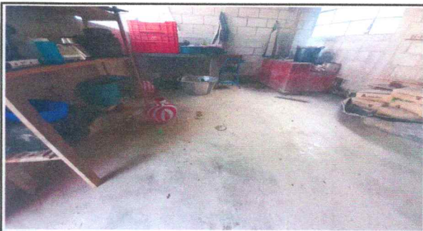
Foto 4: Sustitución de piso
