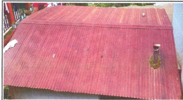
Foto 3: Sustitución de lámina
