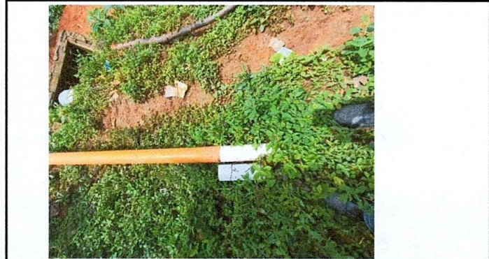
Foto 4: Sustitución de tubería PVC.
