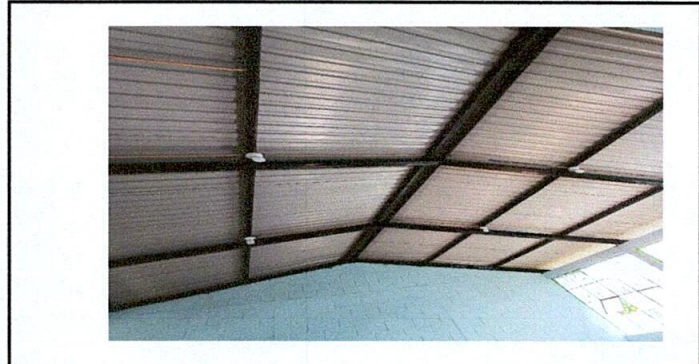
Foto 6: Reparación de cableado eléctrico
