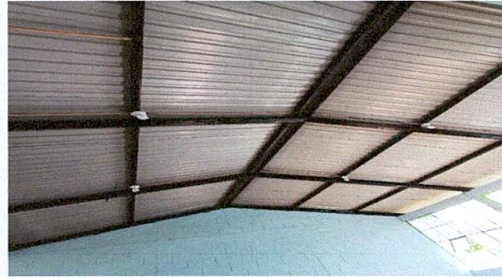
Foto 10: Sustitución de plafoneras.
