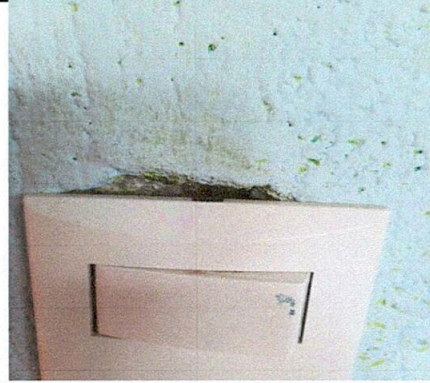
Foto 8: Sustitución de interruptores simples
