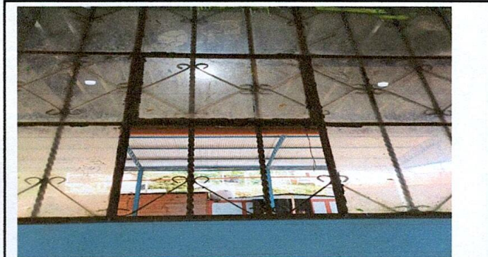
Foto 5: Mantenimiento de balcones
