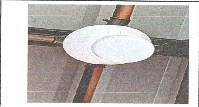
Foto 9: Sustitución de lamparas tipo LED
