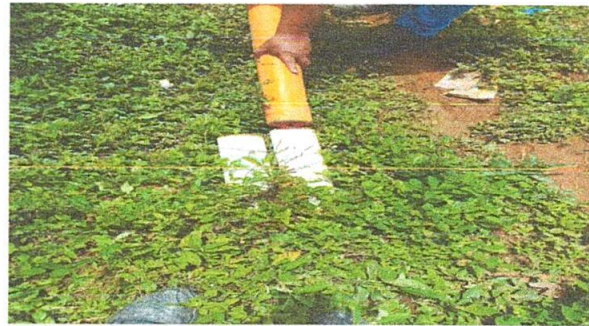
Foto 4: Sustitucion de tuveria PVC.
