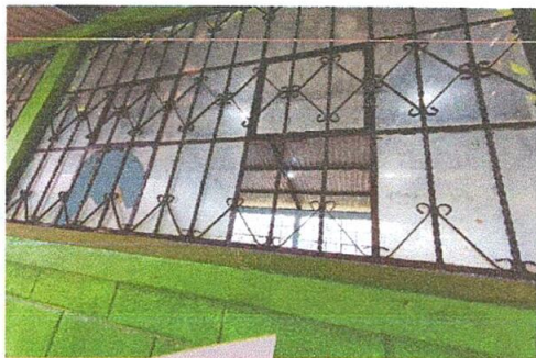
Foto 5. Sustitucion de balcones.
