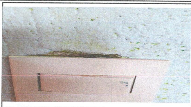
Foto 8: Sustitución de Interruptores.
