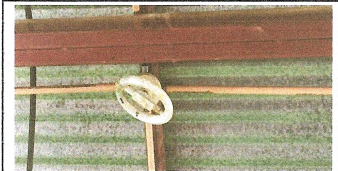
Foto 9: Sustitución de lamparas tipo LED
