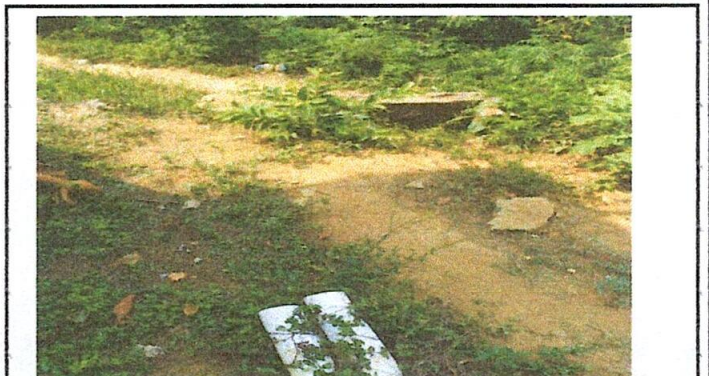
foto 4: sustitución de tubería PVC
