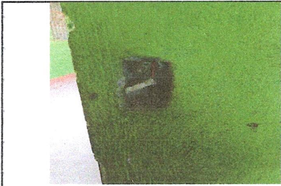
Foto 8: Situación de interruptores simples
