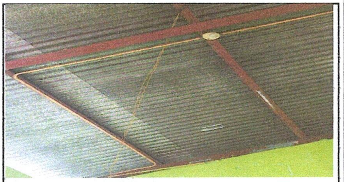
Fto 6: Reparación de cableado eléctrico
