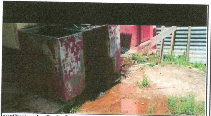
sustitucion de pila de Cemento de dos lavaderos.
