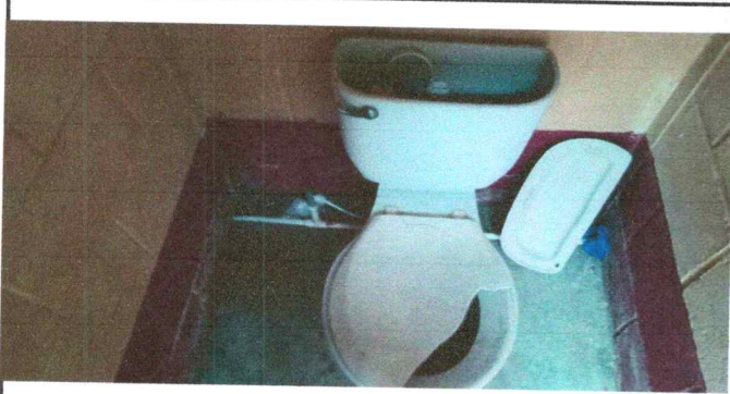
sustitucion de inodoros
