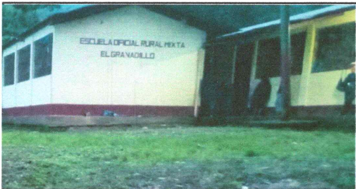
Pintura en muros exteriores e interiores
