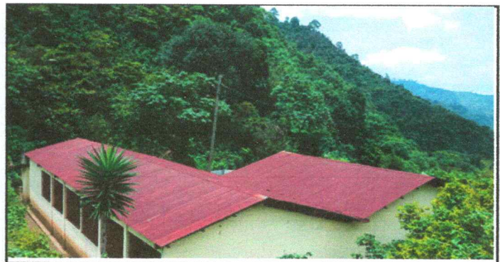
Pintura en muros interiores y exteriores
