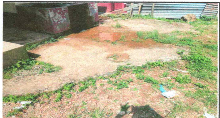
Sustitucion de piso de torta de concreto
