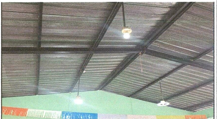
Foto 4: Sustitución de focos ahorradores
