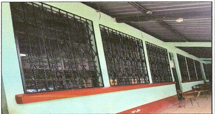
Foto 6: Mantenimiento de balcones por ventanas
