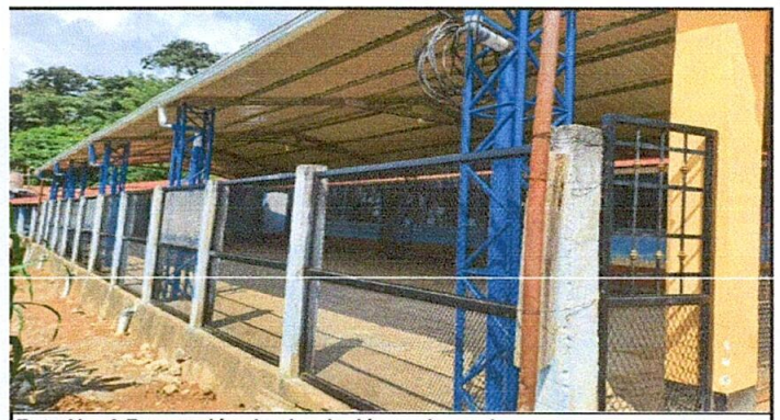
Foto No. 6 Reparación de circulación perimetral
