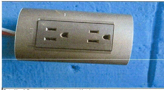
Foto No. 5 Reparación de sistema eléctrico
