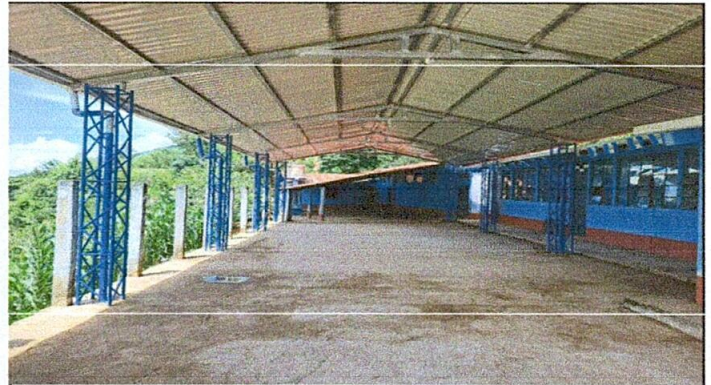
Foto No. 2 Mejoramiento de estructura de techo.
