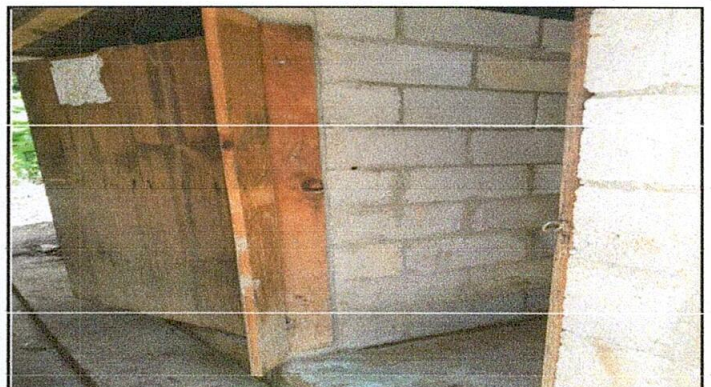
Foto No. 4 Servicios Sanitarios
