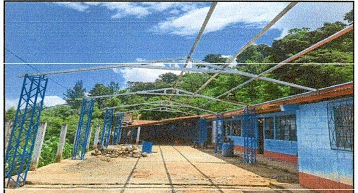
Foto No. 2 Mejoramiento de estructura de techo.
