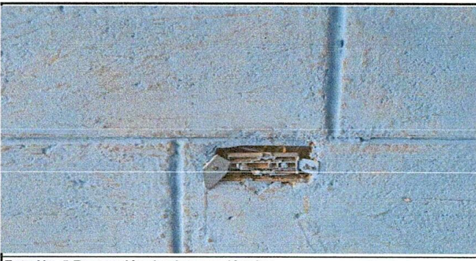
Foto No. 5 Reparación de sistema eléctrico
