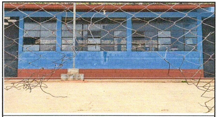
Foto No. 6 Reparación de circulación perimetral
