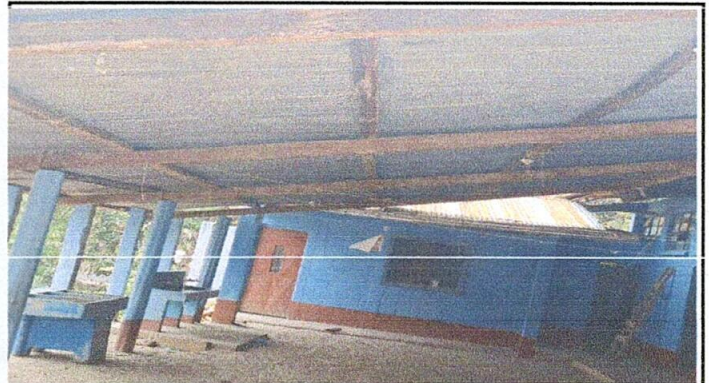
Foto No. 2 Mejoramiento de estructura de techo.
