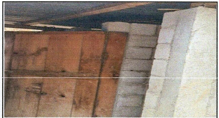
Foto No. 4 Servicios Sanitarios
