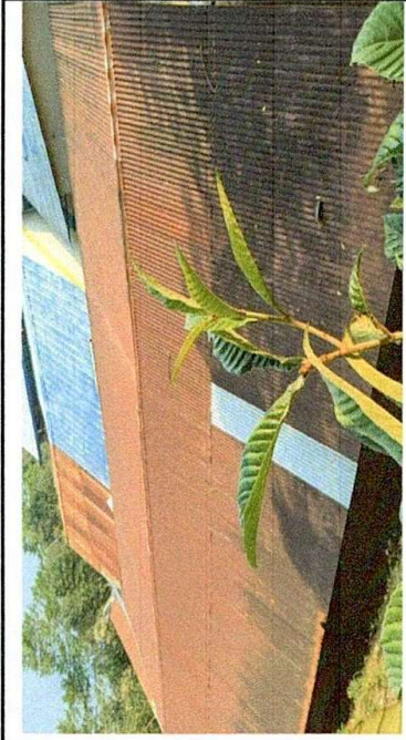
Foto 1: Cambio de lámina por lamina troquelada calibre 26
