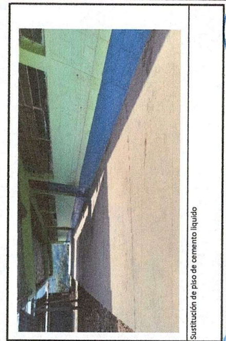
Sustitución de piso de cemento liquido
