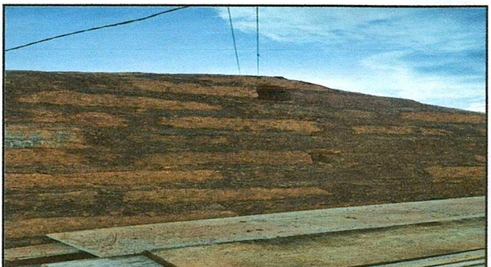
Foto 4: sustitución de estructura de soporte
