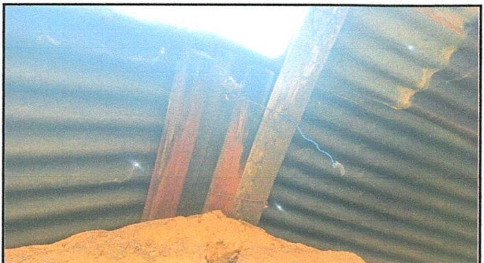
Foto 4: Sustitución de estructura de soporte
