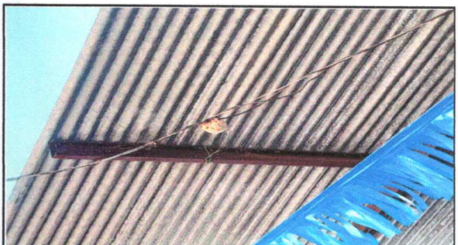
Foto 4: Sustitución y mantenimiento de energía eléctrica
