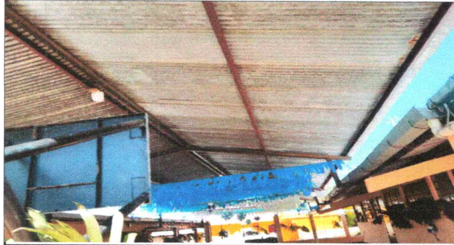
Foto1: Sustitución de lámina por lámina troquelada calibre 26
