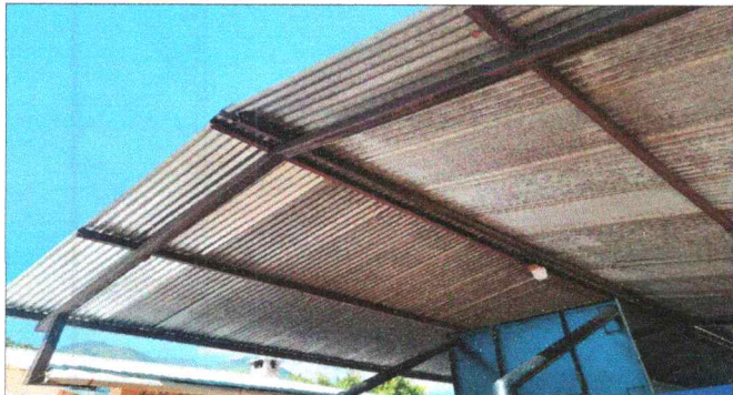
Foto 3: Mantenimiento a estructura portante de metal
