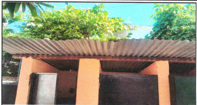
Foto 2: Sustitución de lámina por lámina troquelada calibre 26 y sustitución de estructura portante de madera por estructura portante de metal
