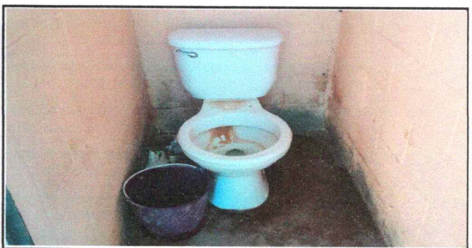
Foto 6: Sustitución de inodoros
