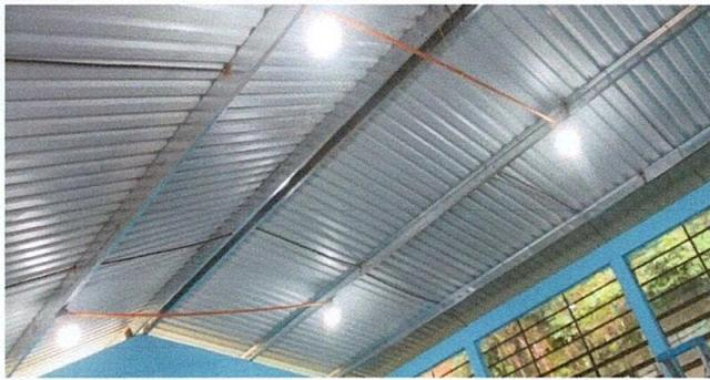
Foto 3: Finalización de estructura de soporte (costaneras)
