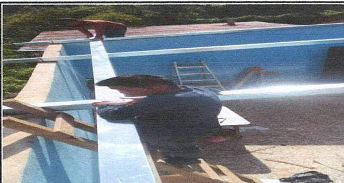
Foto 5: colocación de soporte de metal
