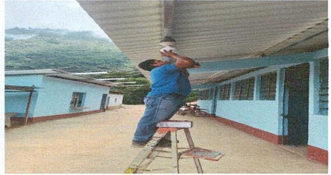
Foto 2: Instalación de cableado eléctrico
