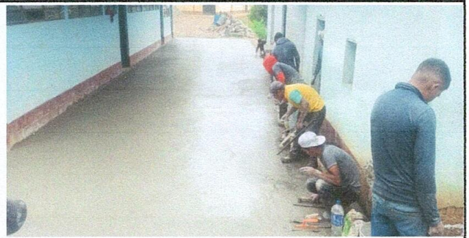
Foto 4: Colocación de piso de concreto
