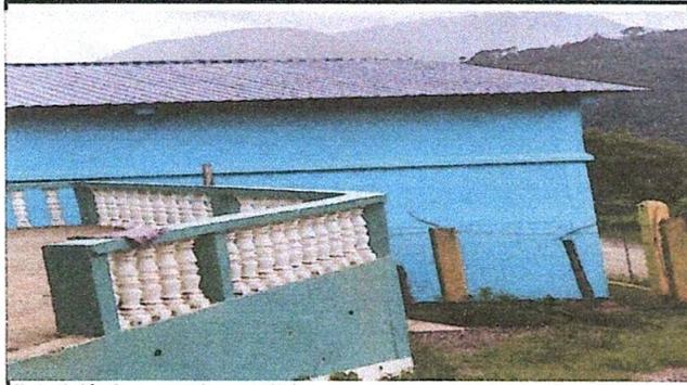
Foto 1: lámina en malas condiciones
