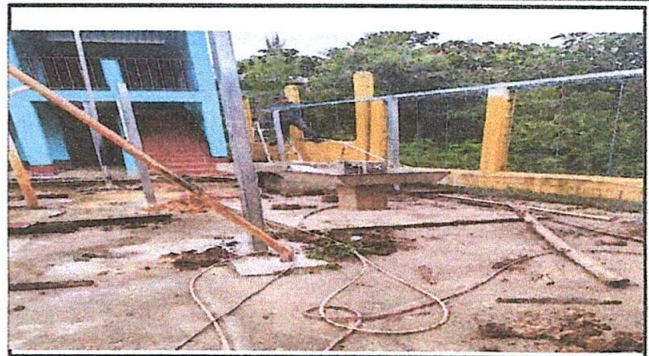
Foto 2: Sustitución de soporte de madera por metal
