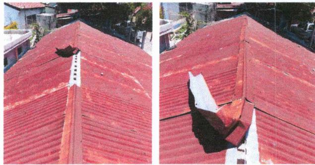
Foto1: El techo de las aulas se encuentra en mal estado, se filtra el agua, por lo que se tiene contemplado la reparación de costaneras y sustitución de laminas.
