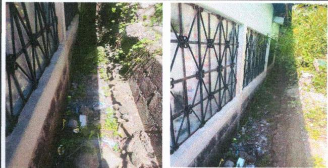
Foto 2: Reparación de cuneta de concreto en mal estado, se tiene contemplado reestructurar para evitar la filtración de agua en las aulas de la escuela.
