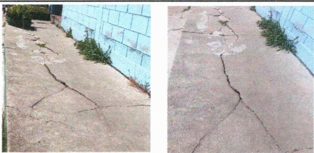
Foto 3: Reparación de banqueta de concreto debido a su mal estado se tiene contemplado reconstruir el paso peatonal entre las aulas.
