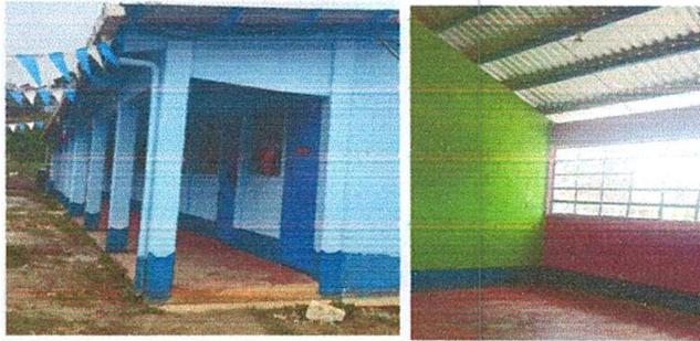
Foto 3: Pintura en muros exteriores e interiores
