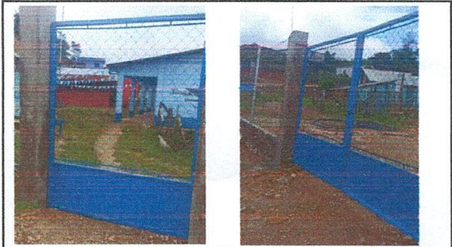
Foto 2: Sustitución de portón de metal
