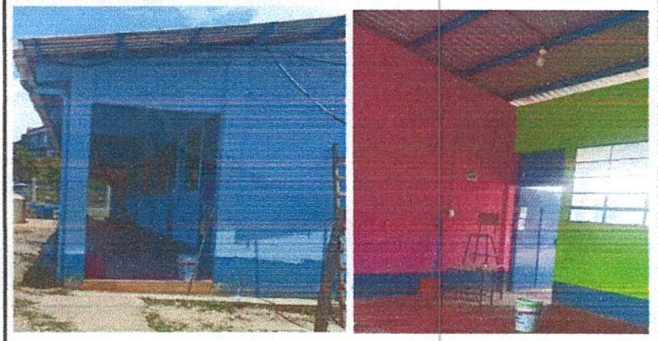
Foto 3: Pintura en muros exteriores e interiores
