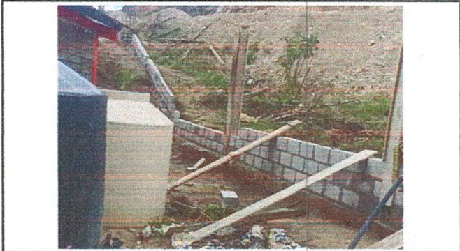
Foto 1: Reparación de muro perimetral
