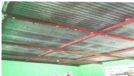
Foto 2: Estructura de Techo: se sustituirá la estructura de madera existente, la cual se encuentra en mal estado por estructura de metal.
