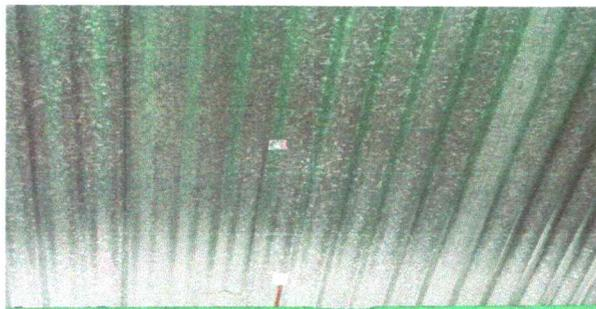
Foto1: Cubierta de Lámina : debido al deterioro de los materiales se realizara la sustitución de la lamina por lamina troquelada.
