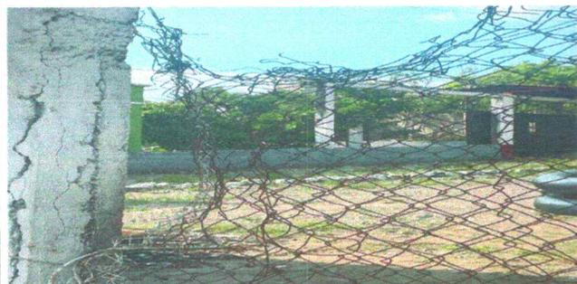
Foto 7: Muros Perimetrales: se sustituirá la maya existente que se encuentra en mal estado por maya nueva y una parte del muro se levantará con block.
