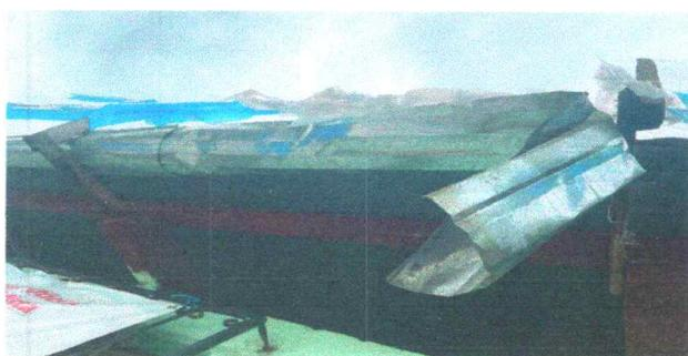
Foto 5: Canales y Bajadas de Agua Pluvial: debido al mal estado de los canales con que cuenta la escuela, se sustituiran ppr canales de PVC.
