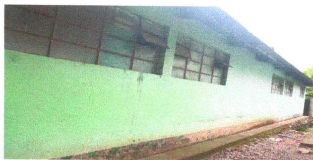
Foto 6: Pintura en Muros Interiores y Exteriores: Por motivo del mal estado de la pintura, es necesario pintar nuevamente todos los muros interiores y exteriores de la escuela.
