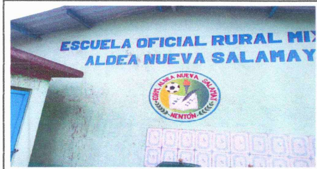
Foto 1: Impermeabilización de pared aula tecnológico
