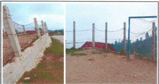
Foto 4: Reparación de la circulación del centro educativo
