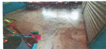
Foto 4: Sustitución de piso de cemento líquido.
