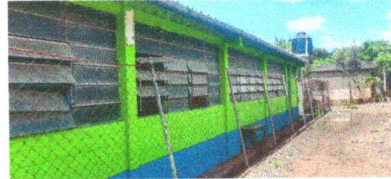
Foto 2: Sustitución de vidrios.
